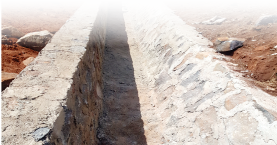
Construção de vala de drenagem revestida—Município de Gurué
